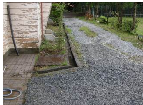
⇒排水溝を清掃すると共に 通路に砂利を引く⇒
