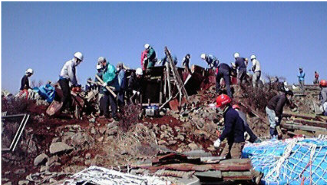
丹沢塔ノ岳 旧山小屋の廃屋の解体 (3月7日)
